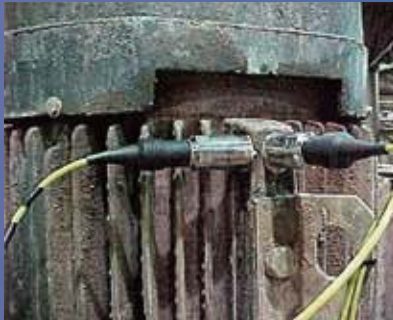
垂直型遠心ポンプ、センサ取り付け例
